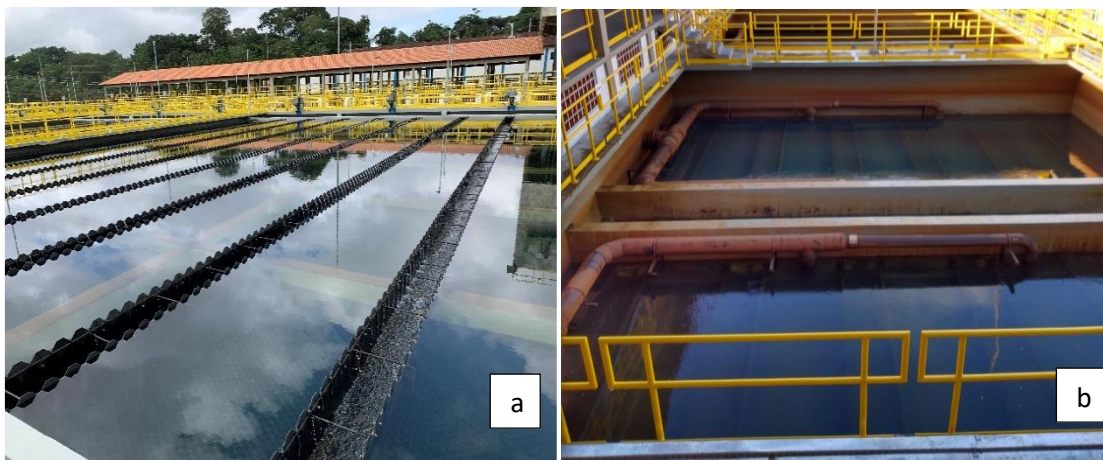
Figura 11 – Decantadores de alta taxa (a) e filtro de camada dupla de fluxo descendente (b) da ETA Bolonha.
